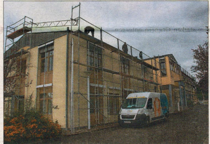
Auf dem Dach des Bauamtes Bendorf wird die erste Photovoltaikanlage errichtet.
