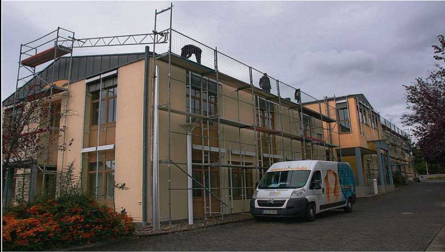
Auf dem Dach des Bauamtes Bendorf wird die erste Photovoltaikanlage errichtet.
